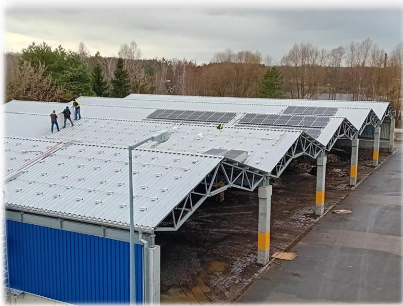
Rozbudowa instalacji fotowoltaicznej PV na terenie oczyszczalni ścieków w Obornikach
