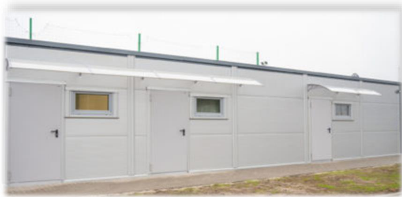
Szatkownia przy ul. Objezierskiej w Obornikach
