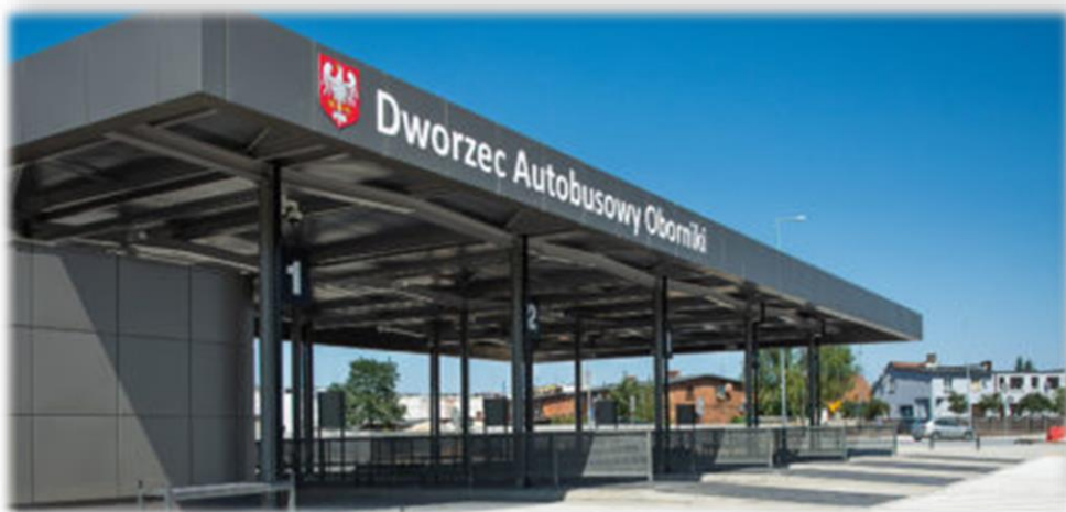
Dworzec autobusowy w Obornikach
