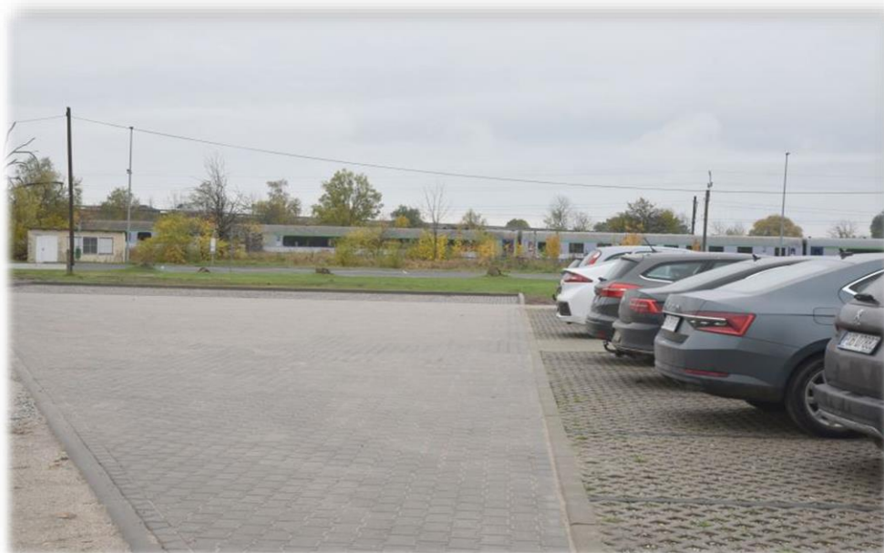
Utwardzenie terenu przy świetlicy w Ocieszynie
