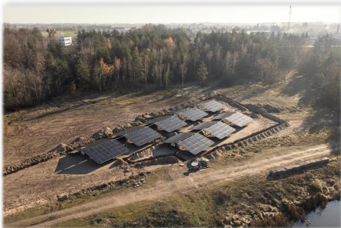
Budowa instalacji fotowoltaicznej PV na terenie SUW w Obornikach
